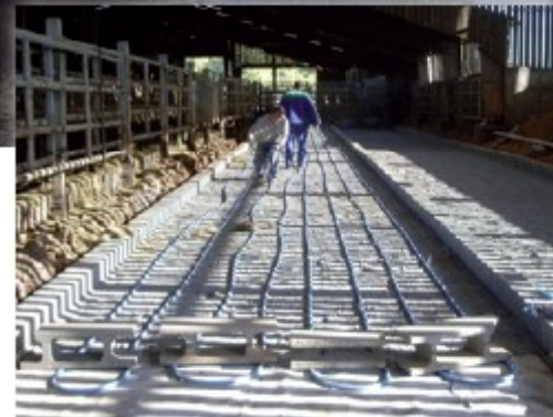
Pose de réseau de capteurs
