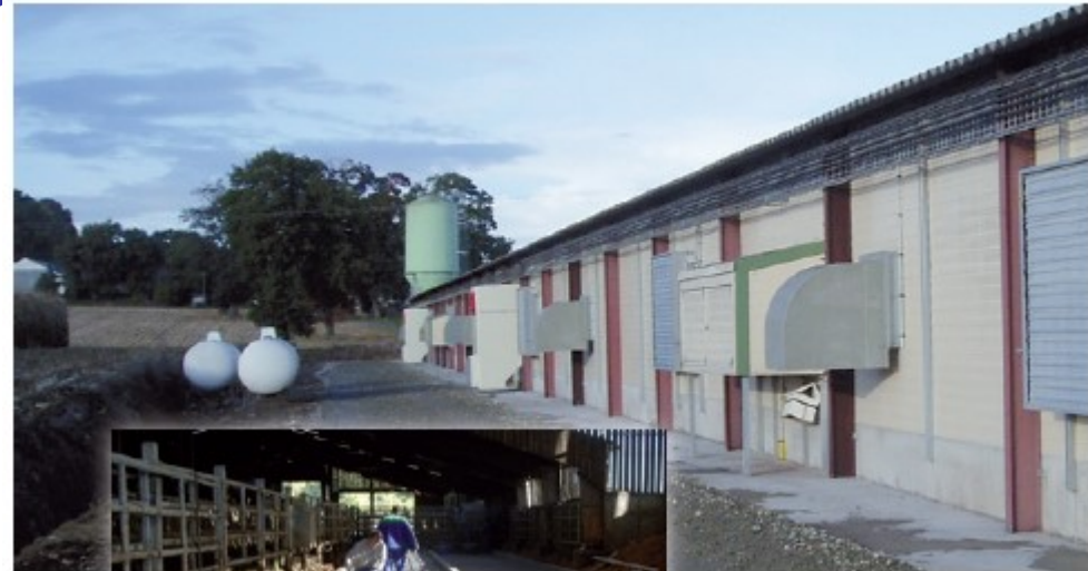
Récupérateur de chaleur
